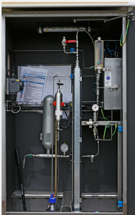
Bild 5: In der eigens für das Projekt konzipierten Odoranlage werden verschiedene Geruchsstoffe getestet
