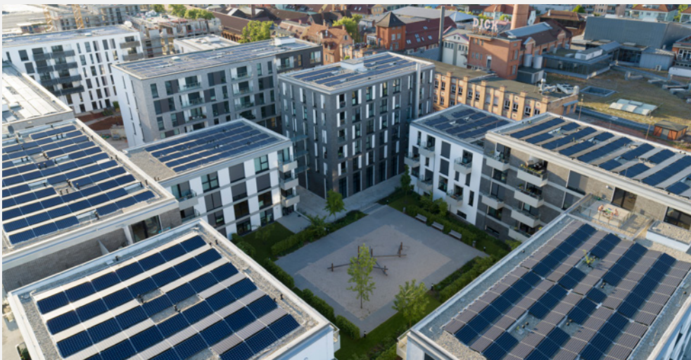
Bild 2: Maximale Solarisierung des Gebäudekomplexes „Block B“
