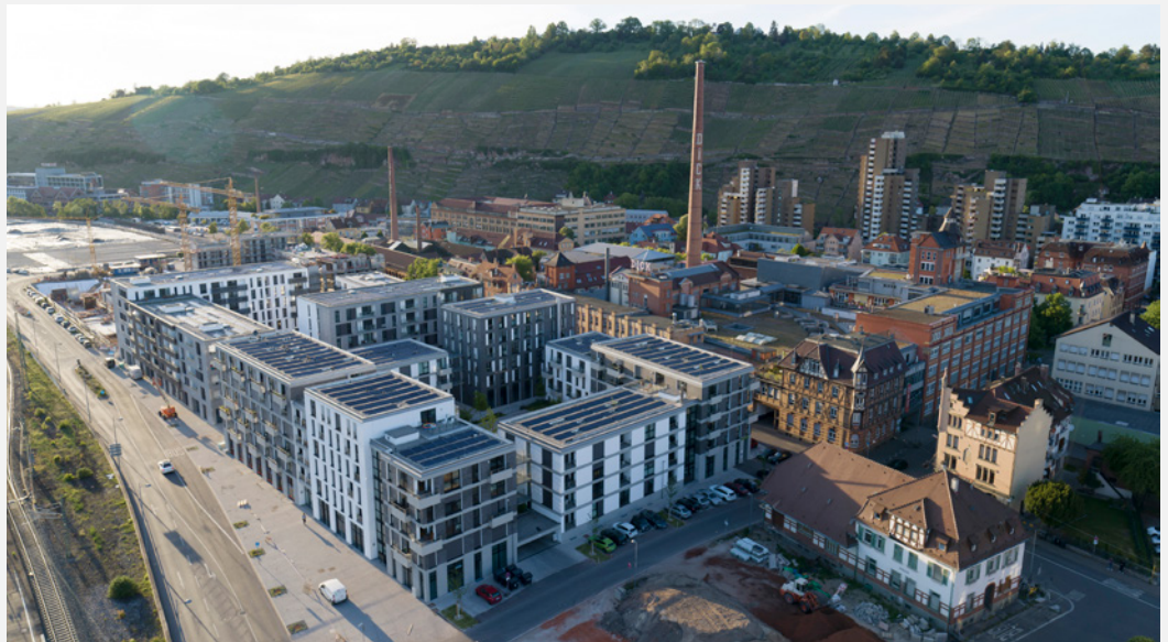
Bild 1: Blick auf das klimaneutrale Viertel „Neue Weststadt“ in Esslingen am Neckar © Maximilian Kamps, Stuttgart und Agentur Blumberg GmbH
