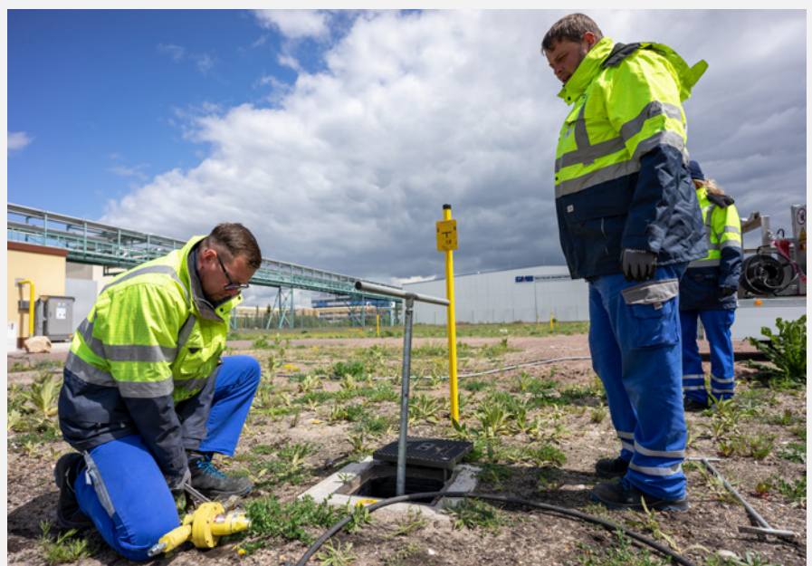
Bild 2: Die Monteure schließen die Wasserstoffackel an das Hochdrucknetz an
