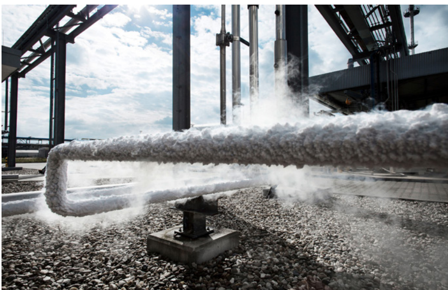
H 2 -Produktionsanlage in Leuna
